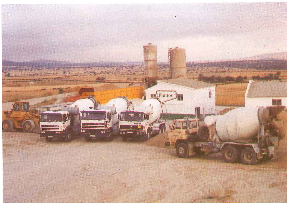
Vista general de la planta de Gujuelo
